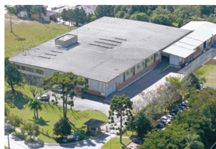
Unidade Industrial da Sulzer Curitiba
